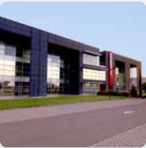
Galtech Site Cavriago (RE) • Italy
