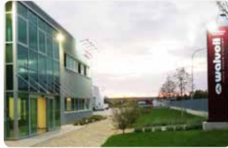
Geschäftseinheit Hydrocontrol - Business Unit Hydrocontrol Castel San Pietro (BO) • Italien - Italy
