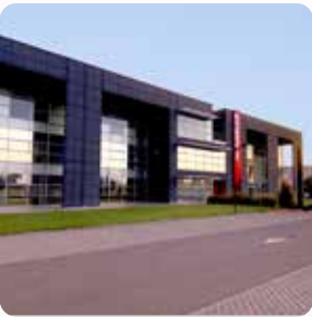
Galtech Site Cavriago (RE) • Italy
